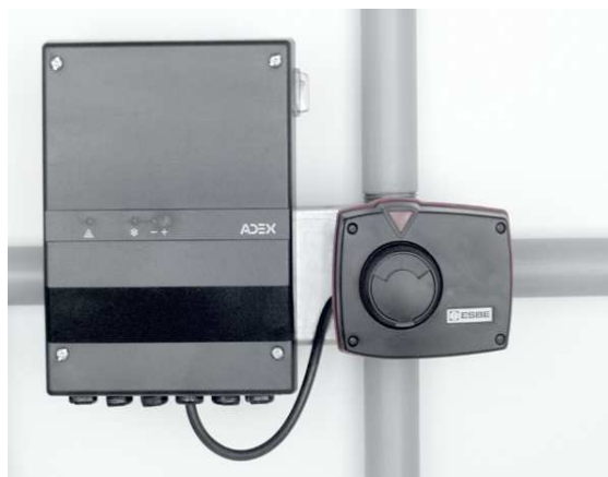
Obr.15 Regulátor upevněný na držáku vedle servopohonu
