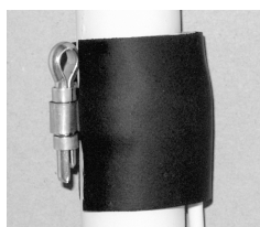
Izolace čidla termo- izolační páskou
