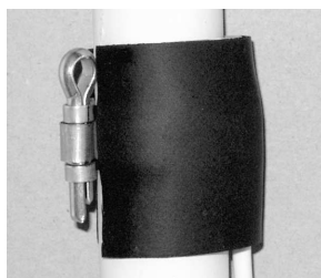
Izolace čidla termo- izolační páskou
